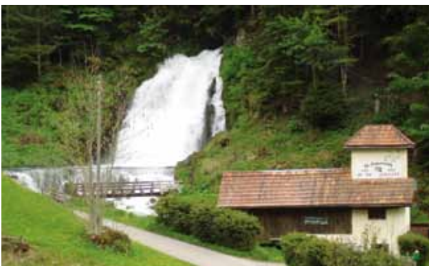
Das private Elektrizitätswerk beim Wasserfall produziert gut zwei Drittel des gesamten Strombedarfs Jauns.
