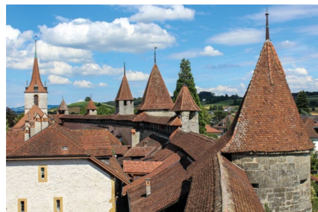
Die Ringmuer mit den Türmen ist weitgehend erhalten.
