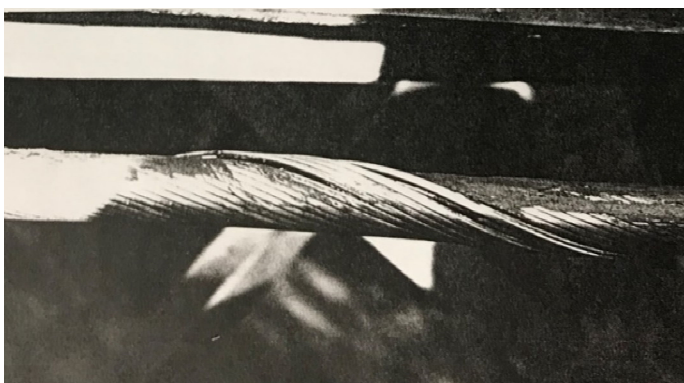
Abb. 48 Drahtbrüche am Zugseil
