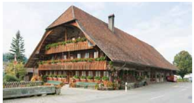
Eine der schönsten Schmuckfassaden des Kantons kennzeichnet das Bauernhaus Lehmann von 1815.
