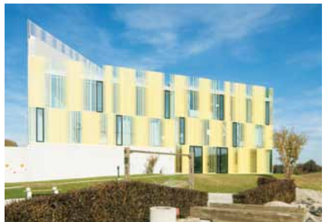
Schmitthen ist eine moderne und offene Gemeinde und zeigt dies unter anderem – wie beim Schulhausbau – in einer vielfältigen Architektur.
