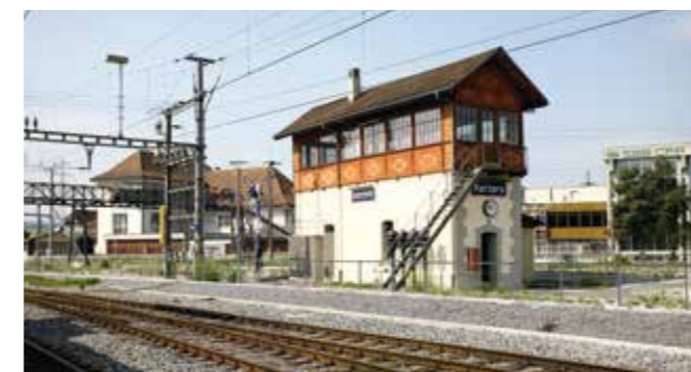
Das geschützte Stellwerkgebäude.
